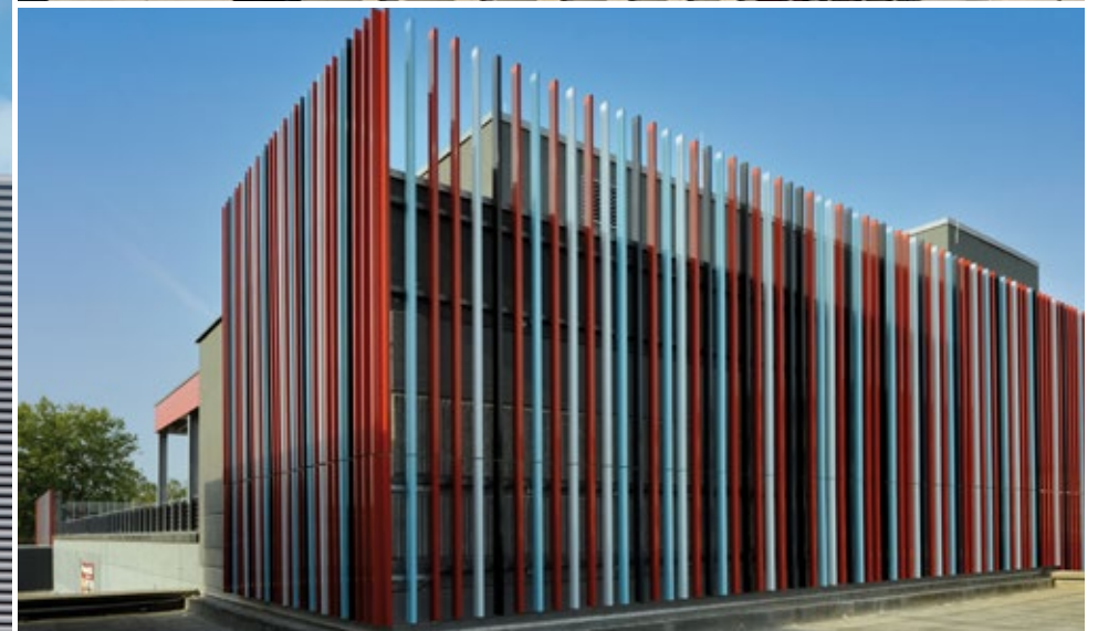
Bild oben rechts: Ernst-August-Galerie in Hannover – 3.135 Lamellen vom Typ Solarfin machen aus dem Sichtschutz einen Blickfang.
