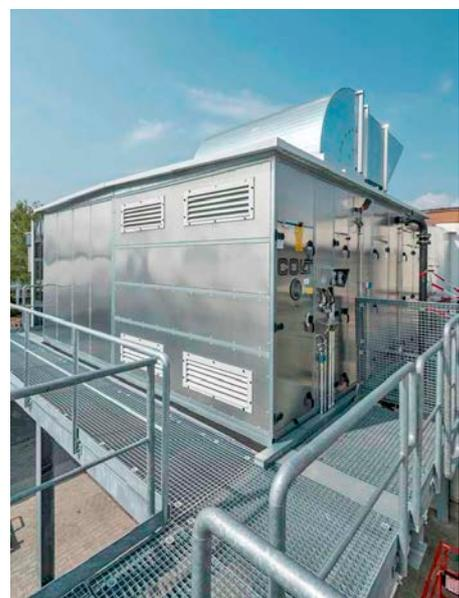
Zuluftgerät „Tristar“ in einer Sonderausführung
