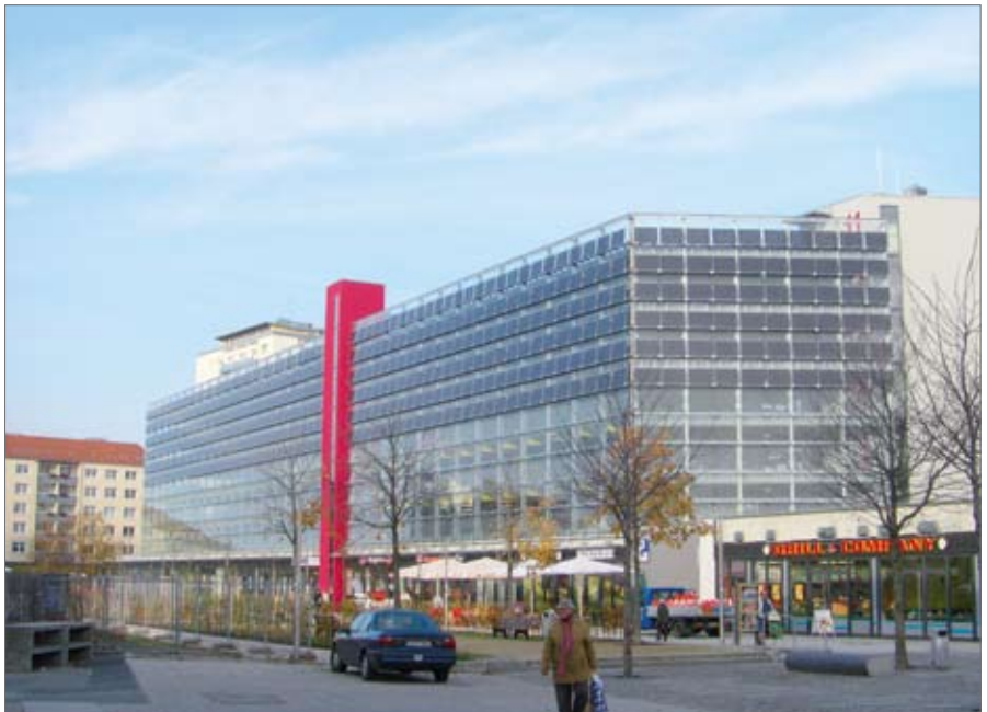
Geplant wurde das Parkhaus Roter Turm, das seinen Namen der weithin leuchtenden Außenfarbe der Treppen- und Aufzugtürme verdankt, als offenes Gebäude mit freier Lüftung.
