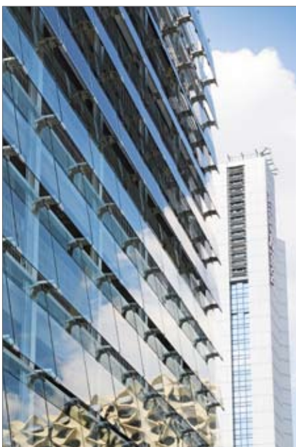
In den unteren sechs von insgesamt zehn Etagen wurden rahmenlose Glasscheiben schuppenartig um das Gebäude gelegt.
